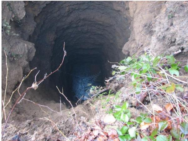
Rupture d'une tête de puits dans les mines de fer de Lorraine (vue en surface à l'intérieur)
